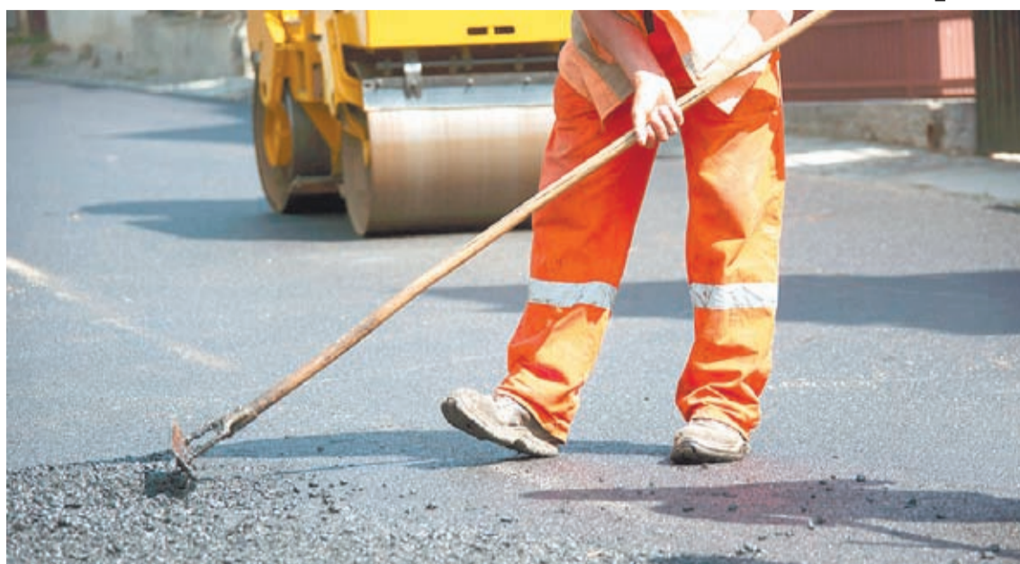
Необходимый запас материалов и техники для проведения ремонта есть
